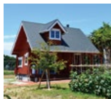
员工第一疗养所2(尾道市向岛)
