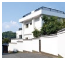
员工第一疗养所1(尾道市向岛)
