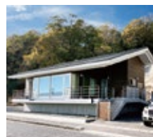
员工第一疗养所3(尾道市向岛)
